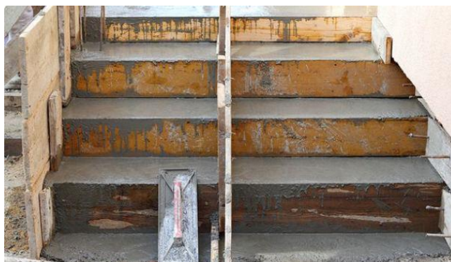
Názorná ukážka odlievania schodiska do vopred nainštalovanej konštrukcie z drevených dosák.
