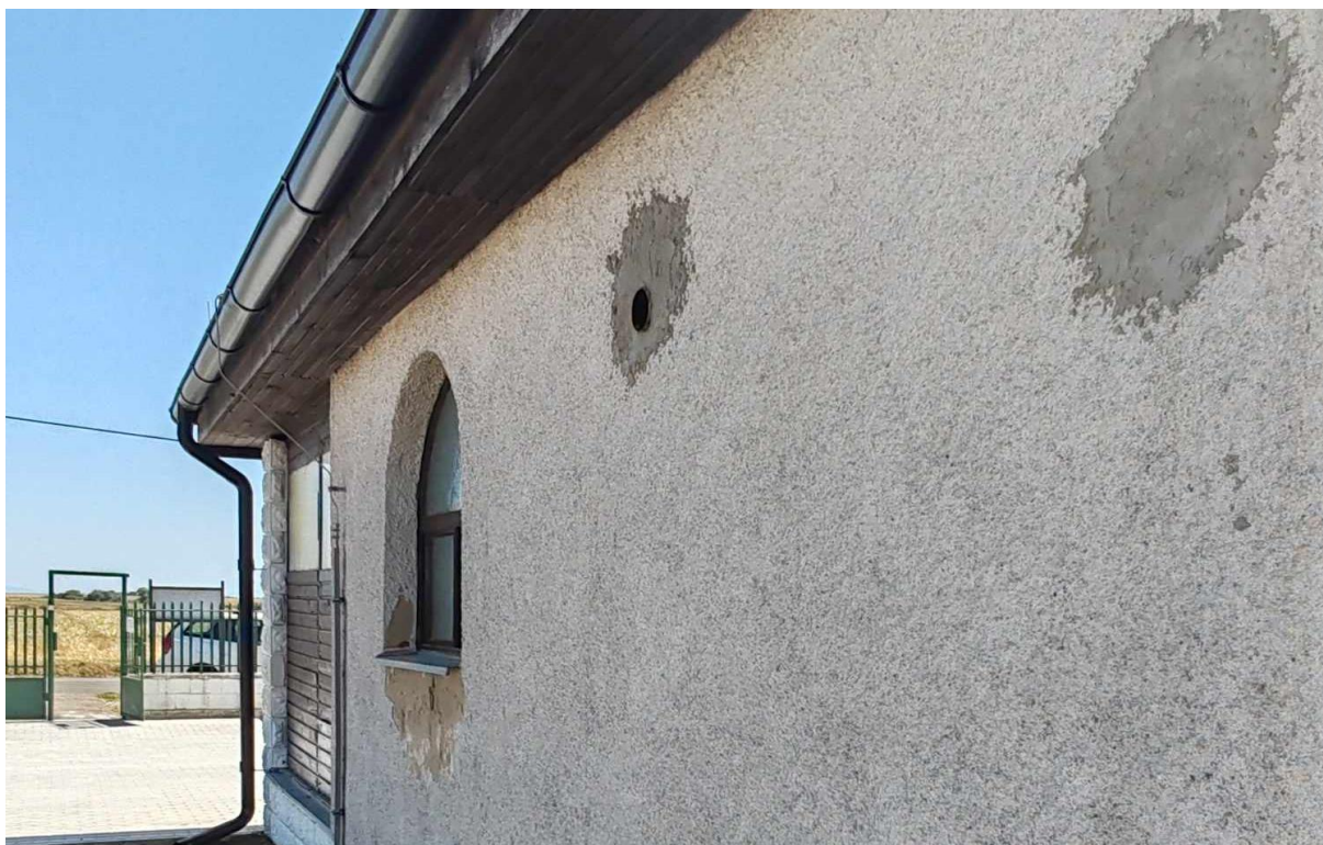
Viditeľné opadávanie existujúcej brizolitovej fasády.
