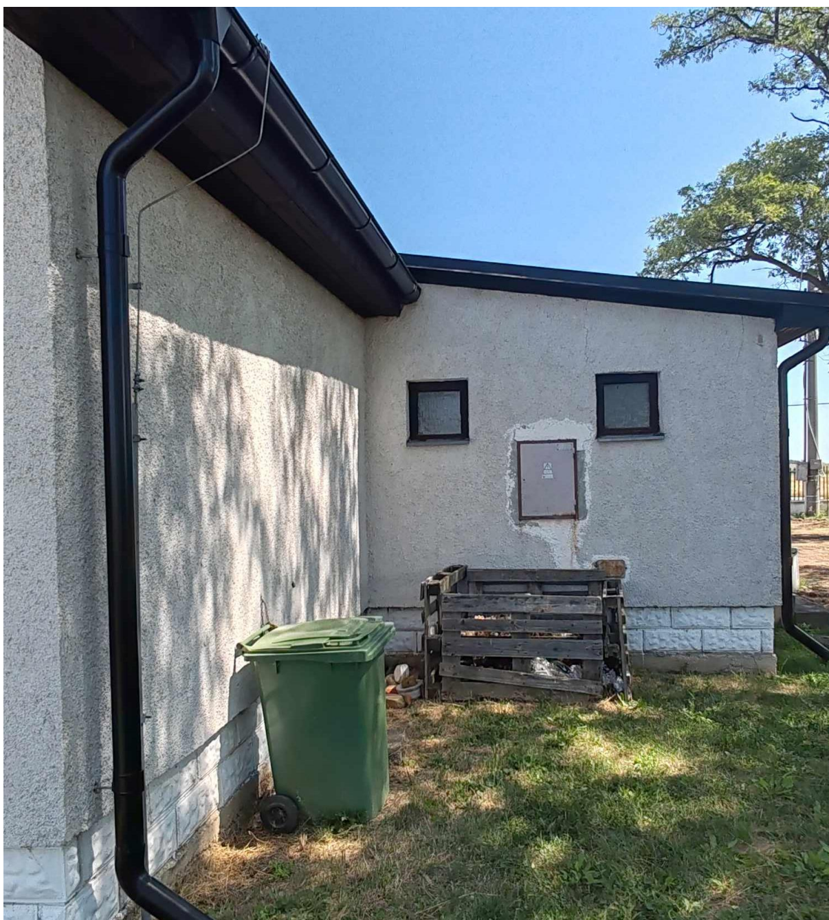
Existujúca zemná elektrická prípojka s konzolou na západnej stene fasády.
